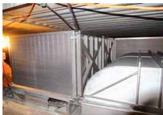
圖4. 濾網安裝現場
