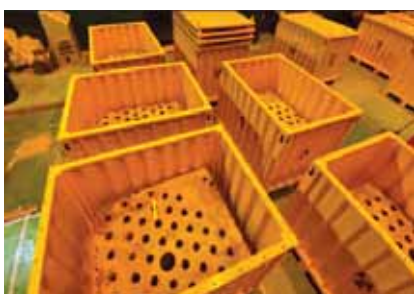
圖5. 上生物屏蔽裝箱作業
