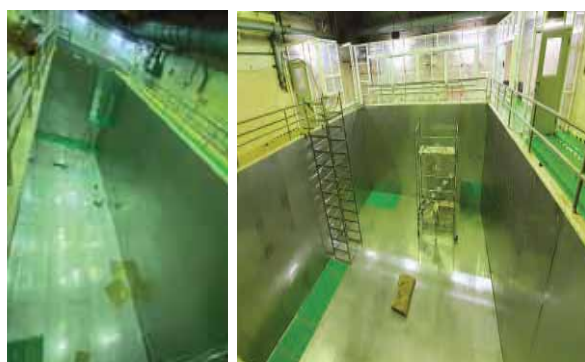
圖5. 燃料池貯存區加設不銹鋼隔離鋼板
