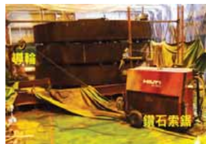
圖4. 上生物屏蔽切割作業
