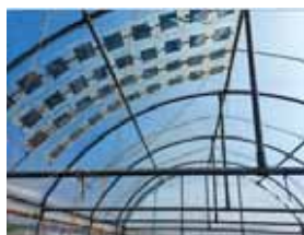
圖2. (a)南北向之隧道型溫室(b)模組貼合於弧形屋頂(c)串聯之模組於兩側金屬電極端點處相接固定(d)OPV與矽晶太陽電池之逐日發電情形
