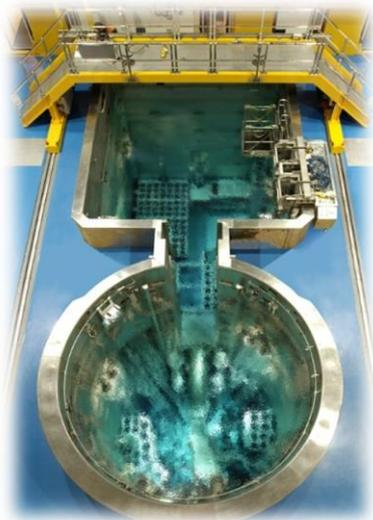
圖 2：位於澳洲雪梨近郊的研究用核反應器，內部充滿重水做為緩衝器，將核分裂所滋生的高能量中子，能量減低的熱中子範圍。此照片在該核反應器運轉前所拍攝。
