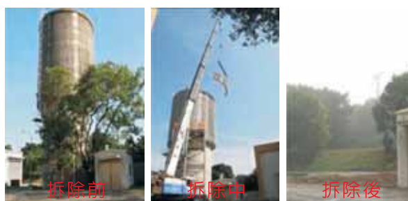
緊急冷卻水塔拆除
