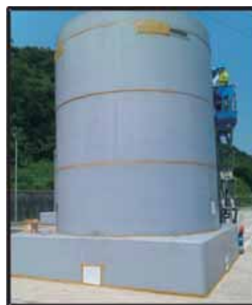
圖2 阻斷乾式貯存系統的自然對流
