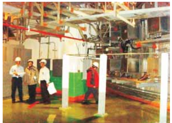
輔機廠房穿越區實地勘察
