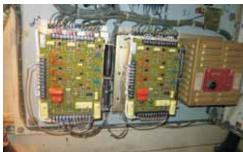
圖2：核二廠電氣機櫃內電子卡片現場安裝記錄
