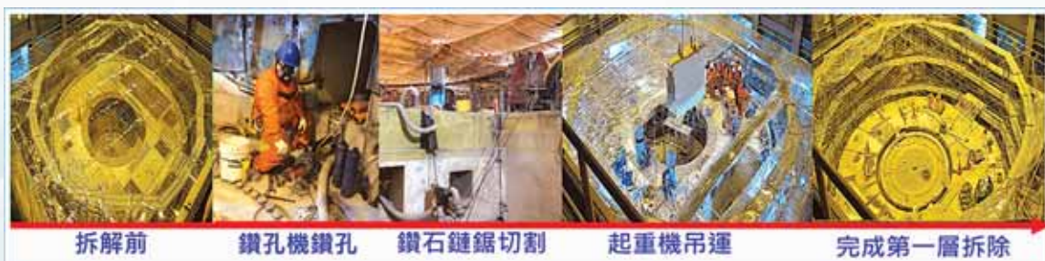
圖3. 生物屏蔽體拆除工程實績
