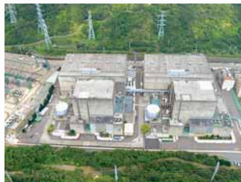
圖3. 核一廠聯合廠房與汽機廠房，左側為1號機，右側為2號機
