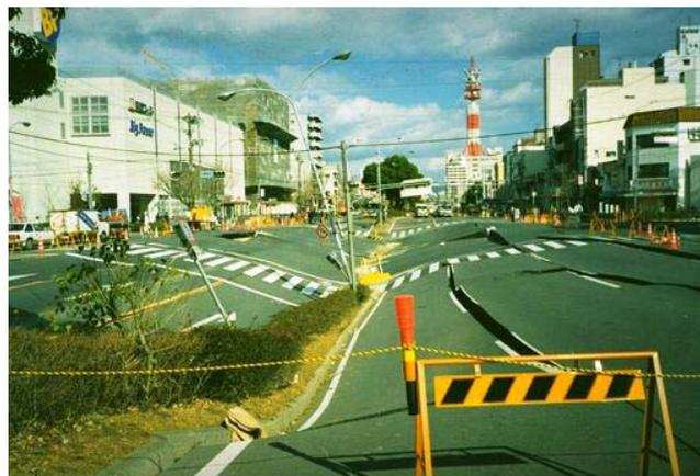
圖六 阪神地震時明挖覆蓋隧道上方地表下陷照片
