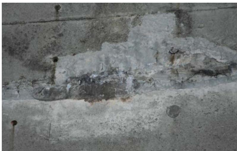
圖三十二 RC 牆面外牆修補後失效之案例圖
