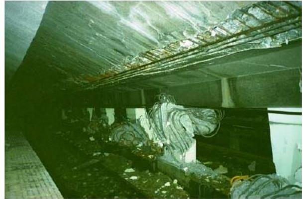
圖五 阪神地震時明挖覆蓋隧道內部受震塌陷照片
