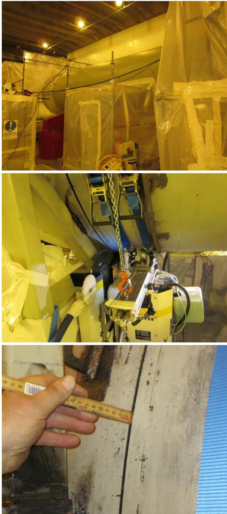
圖 12 西屋公司在熱交換器切割之隔離帳篷建置、切割機具架設與切割深度經驗
