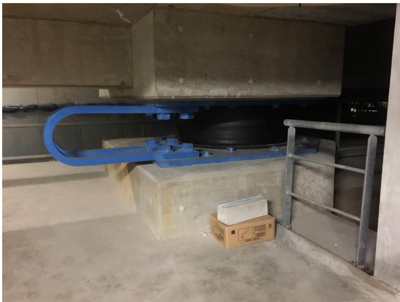
圖 32 Rubber bearing 和 2 方向 U-shape steel damper
