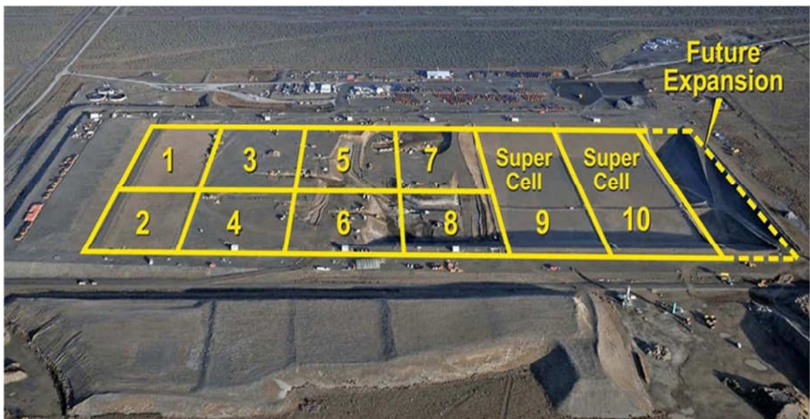
圖 26、環境恢復處置設施(ERDF)
