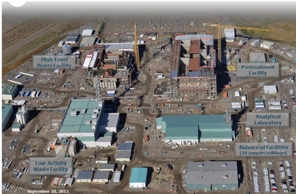
圖 28、建造中玻璃固化工廠及相關處理設施
