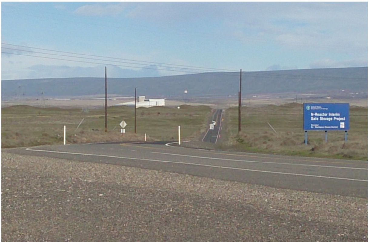
圖 92、N reactor 現地安全貯存
