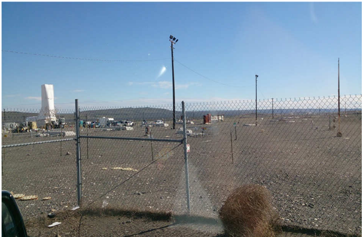
圖 94、Tank farm 一隅
