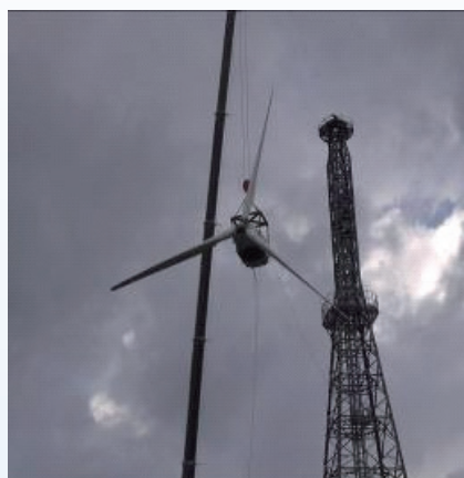
▲ 圖 3：150 kW 風機吊裝
