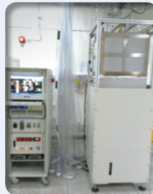
▲建置於中鋼公司之kW級SOFC發電系統
