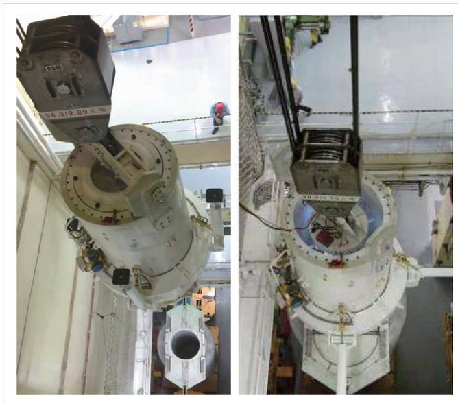
◀ 圖6 於核一廠反應器廠房內執行重件吊運測試
