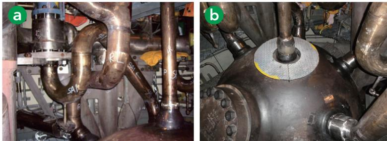
▲ 圖1 核三廠調壓槽上端管嘴異質焊道預覆焊：(a)覆焊前 (b)覆焊後。
