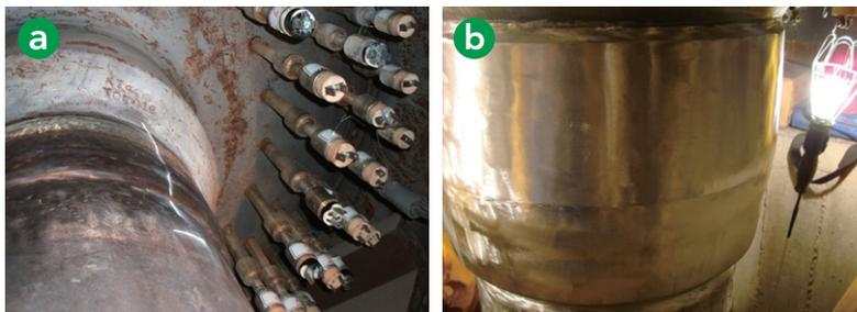
▲ 圖2 核三廠調壓槽調節管嘴異質焊道預覆焊：(a)覆焊前 (b)覆焊後。
