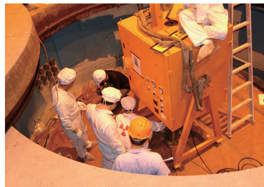
▲ 爐內組件取樣現場作業
