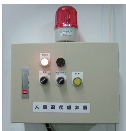
▲ 人體溫度感知器系統(有人靠近貨品入口射源架馬上下降)
