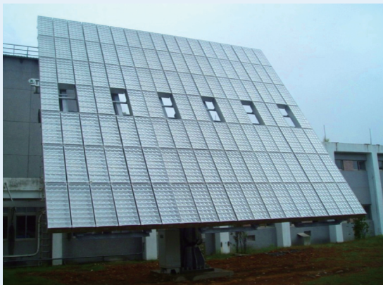
▲ 15 kW級HCPV系統
