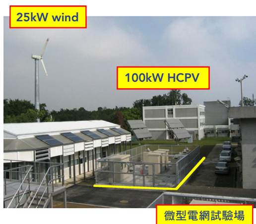
▲ 百瓩級微型電網試驗場
