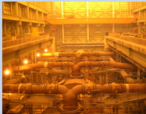
▲ 龍門電廠汽機廠房俯瞰圖，本所評估汽機廠房之屏蔽設計並提供設計變更之建議。
