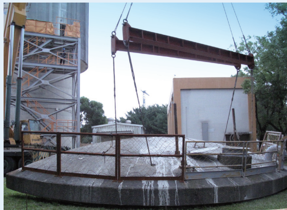
▲ 切割混凝土塊吊掛作業
