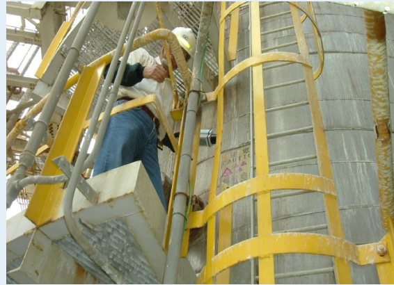
▲ 輻射源安全檢查現場作業
