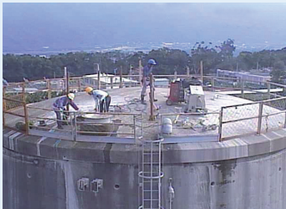
▲ 頂蓋切割作業
