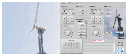
▲ 本所開發的商用25kW主動控制型風機與監控介面
