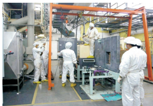
▲ 門型吊車吊離鉛屏作業
