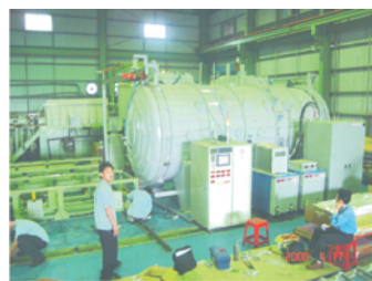
▲ 遠東鈦金翻修案被覆爐移交安裝於廠商廠房
