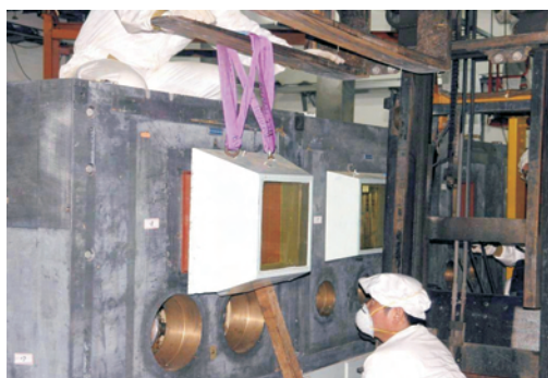
▲ 分析線鉛室鉛玻璃移除
