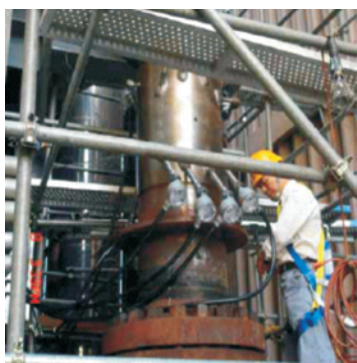
▲ 核三廠超音波流量計系統
