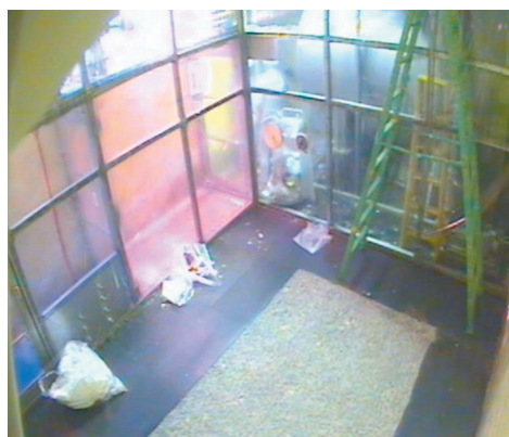
▲016館Unit20手套箱拆除後
