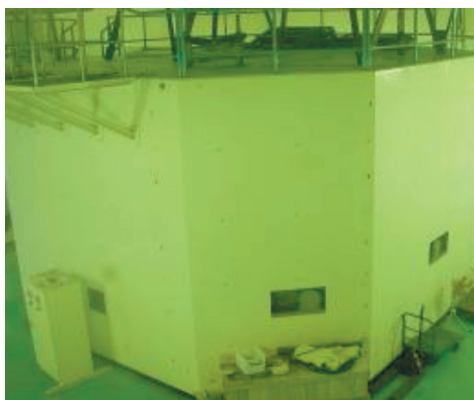
▲019館WBR生物屏蔽體拆除前
