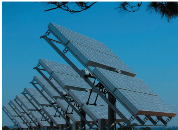
▲立柱式5 kW及屋頂式1.5 kW HCPV系統
