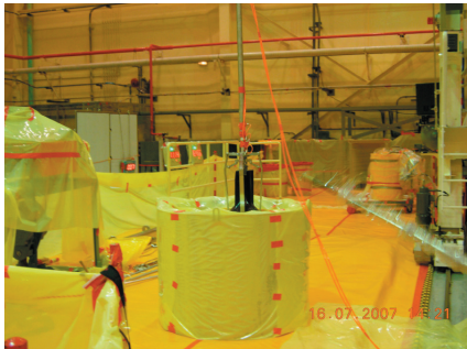
▲切除後的控制棒限速頭裝入廢料桶
