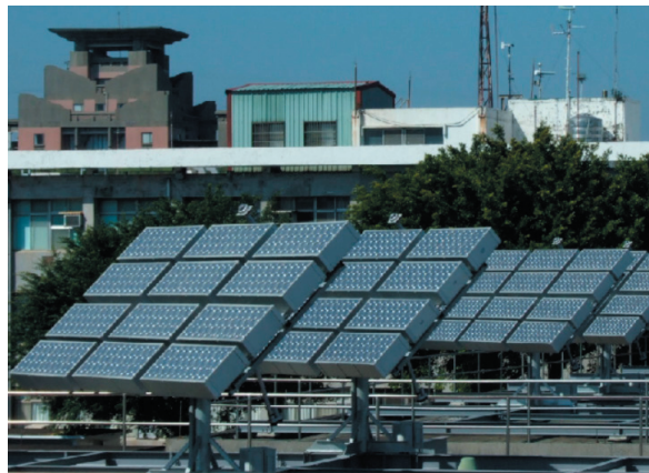
▲立柱式5 kW及屋頂式1.5 kW HCPV系統
