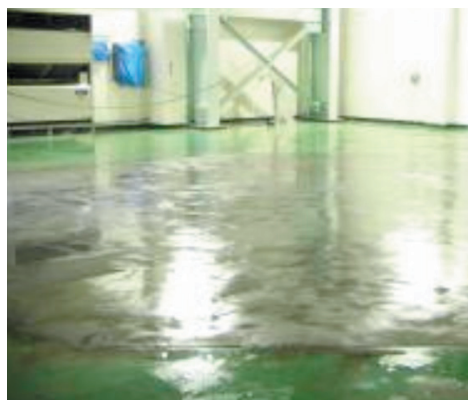
▲019館WBR生物屏蔽體拆除後
