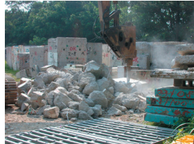
破碎機破碎作業
