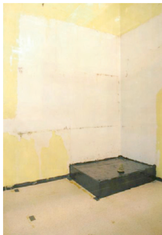
▲Unit 21拆除後現況
