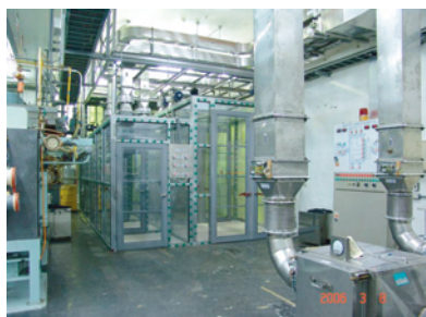
▲隔離帳篷與負壓通風系統
