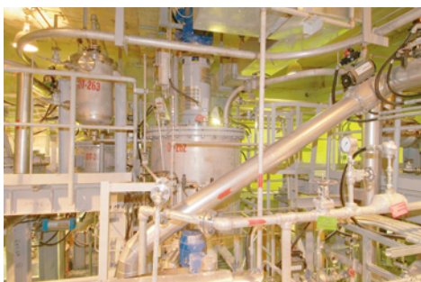
▲核二廠濕性廢料高減容固化系統
