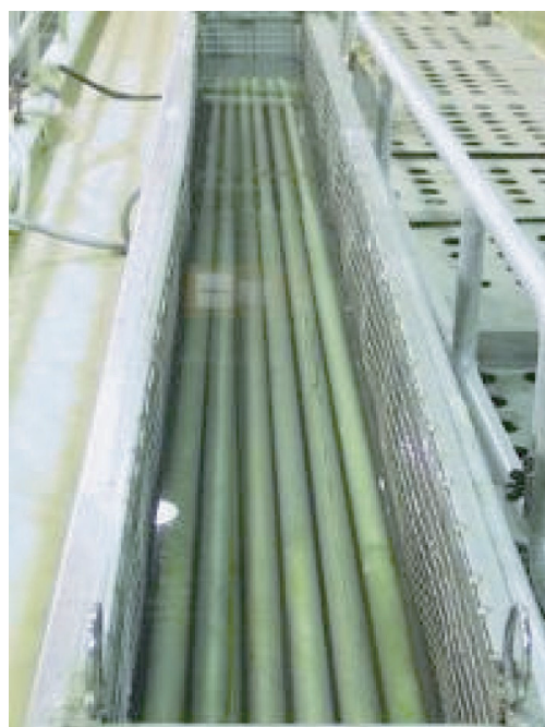
▲燃料池外套管屏蔽段清洗作業
