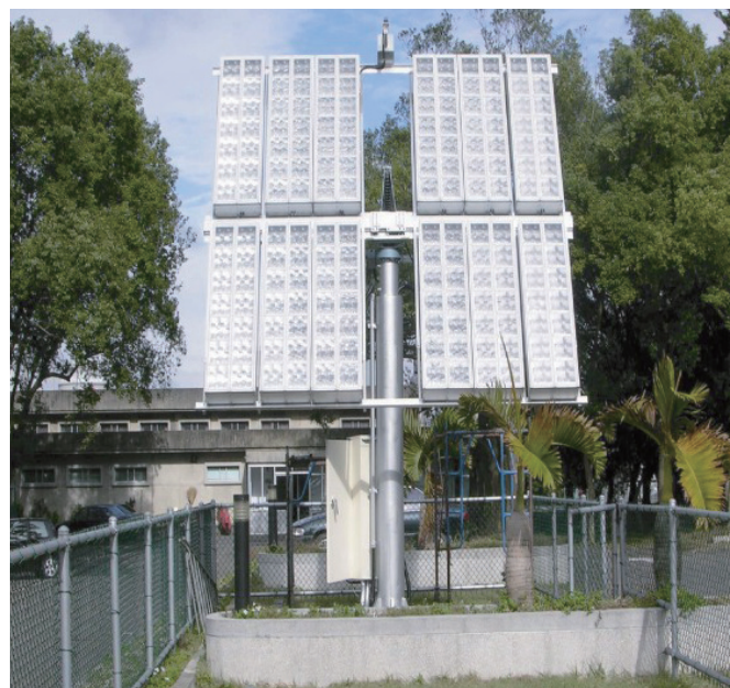
▲位於本所之1kW高聚光太陽能發電驗證系統
