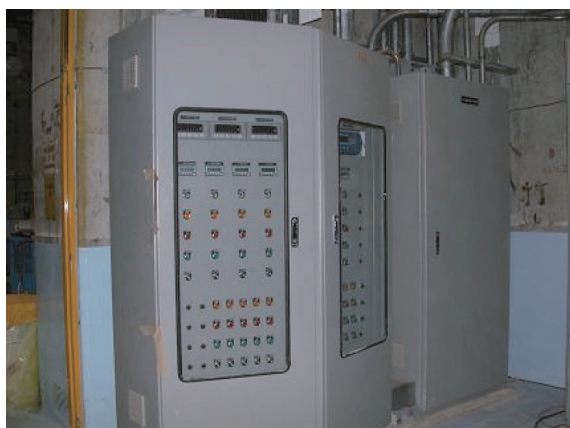
▲高減容固化系統操作控制盤
