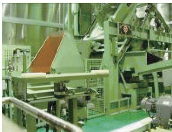
▲污染隔離罩內噴砂研磨機械除污設備
