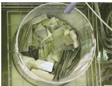
▲燃料池擠壓鉛套管清洗作業
