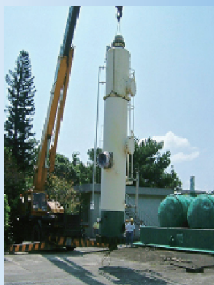
◀重機械吊拆作業
