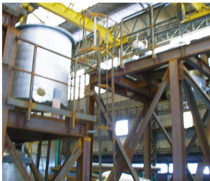
▲高減容固化系統設備之組裝
