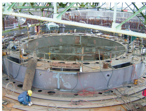
▲一號機基座施工現場實景
