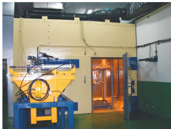
▲燃料外套管運送及切割設備
