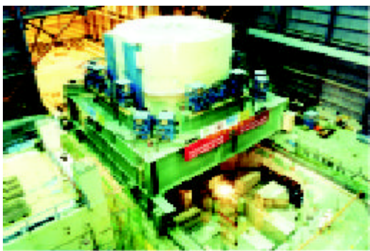
■TRR移爐工程
