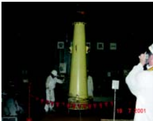
■ 燃料裝卸機拆解
