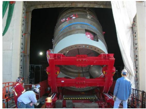
圖十二、使用兩組臨時性吊運裝置將蒸氣產生器傾倒至水平狀態
