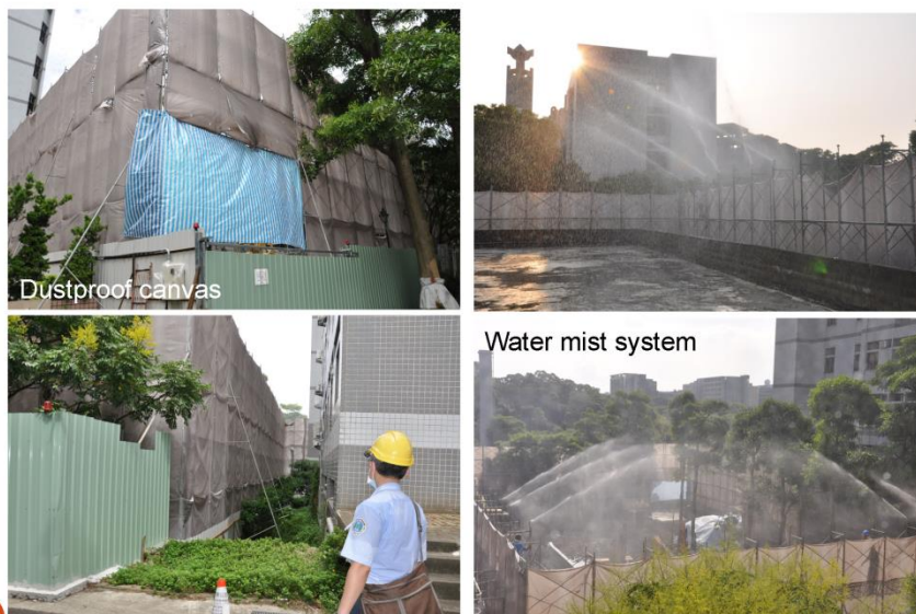
圖 52 拆除作業期間的粉塵抑低措施
