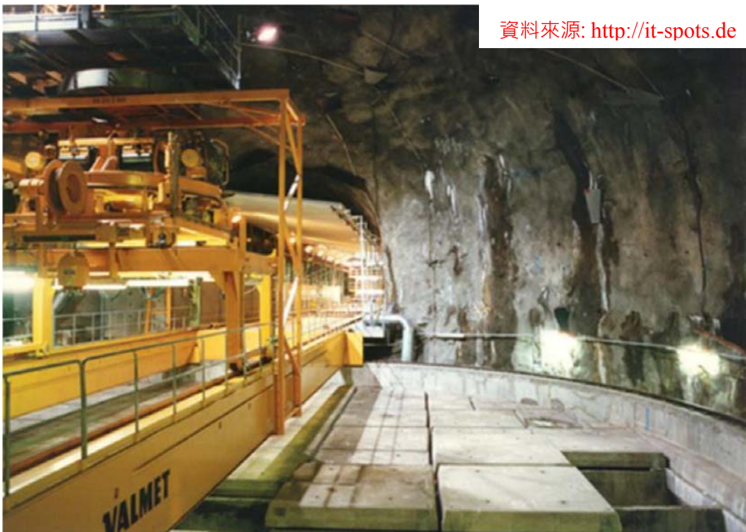
SFR 圓筒狀水泥貯存結構，直徑約 20 公尺，高約 50 公尺
