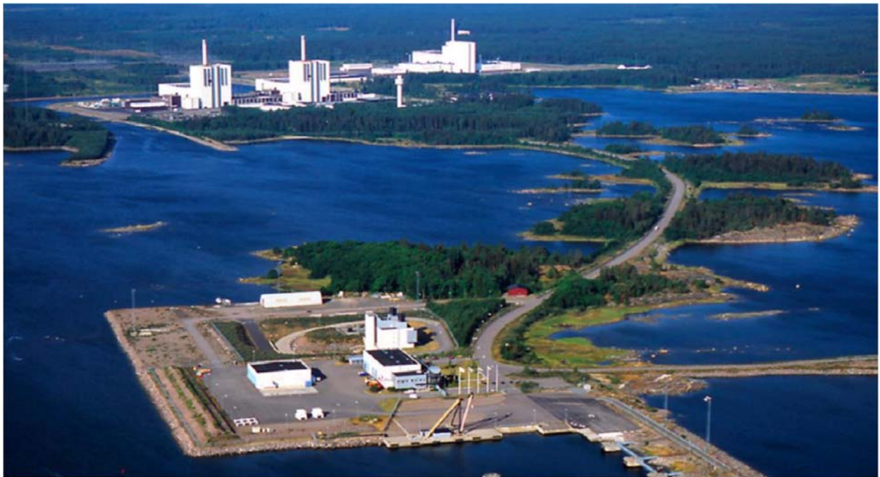
SKB 低階放射性廢棄物貯存場入口
