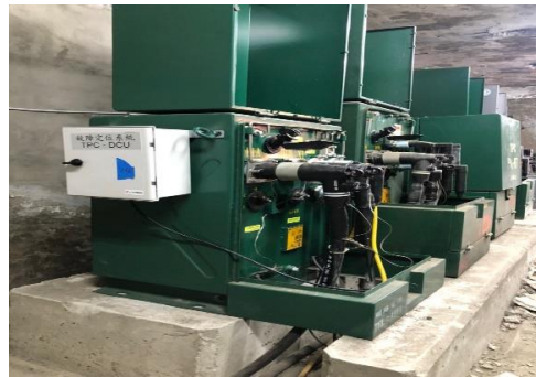
圖 4、DCU 現場佈建(台南地下饋線)
