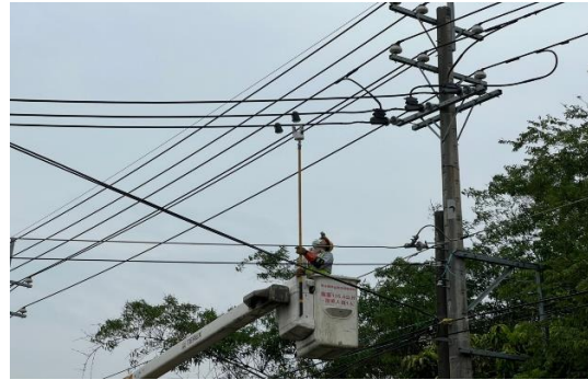
圖 2、FI 現場佈建(高雄岡山)
