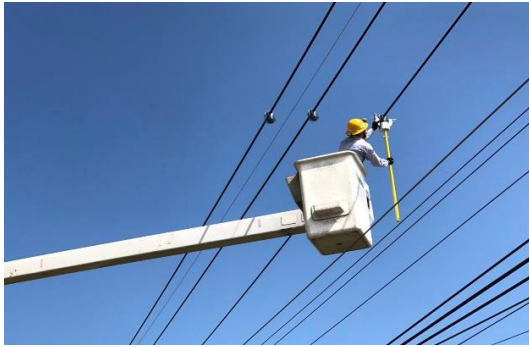
圖 1、FI 現場佈建(高雄柴山)
